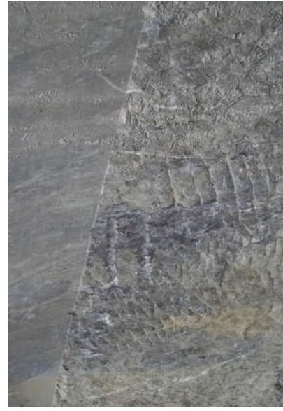
Créer des aspérités (griffages, bouchardage...) sur les parois lisses verticales en larges zones irrégulières
